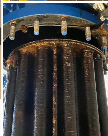
Eksempel på blokkerte filterstaver pga. manglende vedlikehold. Stor forskjell på filter som er brukt og ikke rengjort ofte nok, og filter som er nytt
